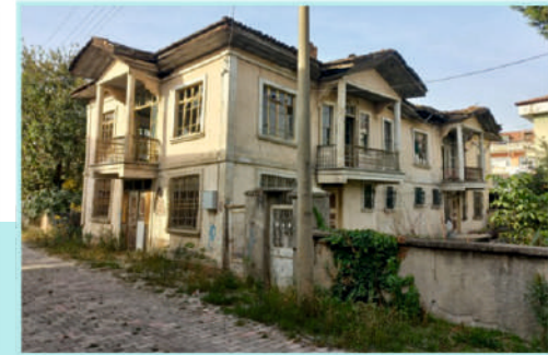
(Abdulkadir Güney Konağı, Yapım Yılı 1930, Kızılırmak Mahallesi)
